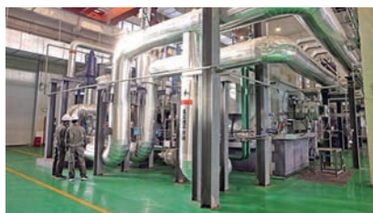
Рис. 12. S-CO 2 генераторная установка Сианьского научно-исследовательского института теплотехники мощностью 5 МВт [24] Fig. 12. 5 MW S-CO 2 generator unit of Xi'an Thermal Power Research Institute [24]
